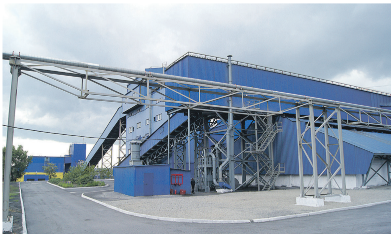
■ Обогатительная фабрика шахты «Садкинская».
